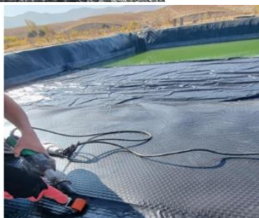
شکل ۱۲- نصب پوشش‌های حباب‌دار
