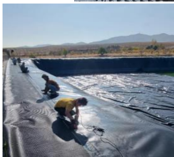
شکل ۱۲- نصب پوشش‌های حباب‌دار
