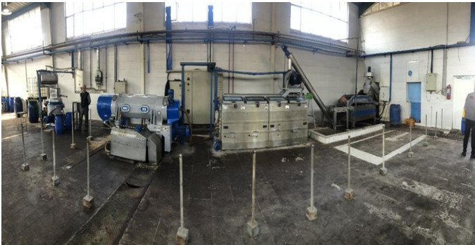
شکل ۱- یک نمونه از خط روغن‌کشی زیتون در منطقه رودبار
