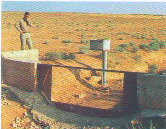
شکل ۴- نمایی از سرریز مستطیلی کارگذاری شده
