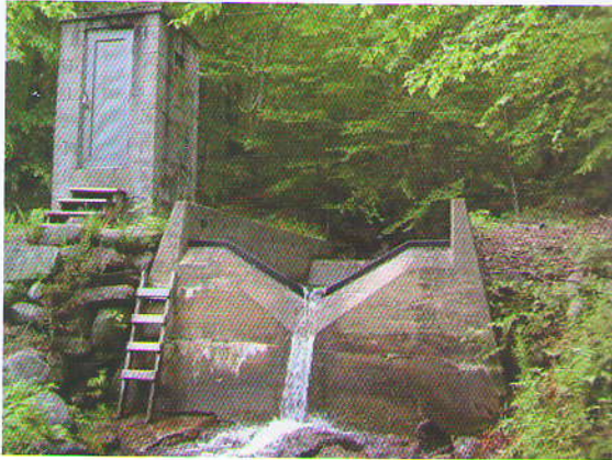
شکل ۸- سرریز مثلثی با زاویه بیشتر از ۹۰ درجه
