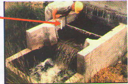
شکل ۶- سرریز ذوزنقه ای کارگذاری شده
