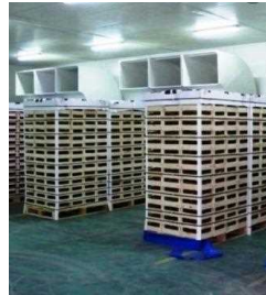
شکل ۱۱- پیش‌سرمایش با هوای سرد اجباری
