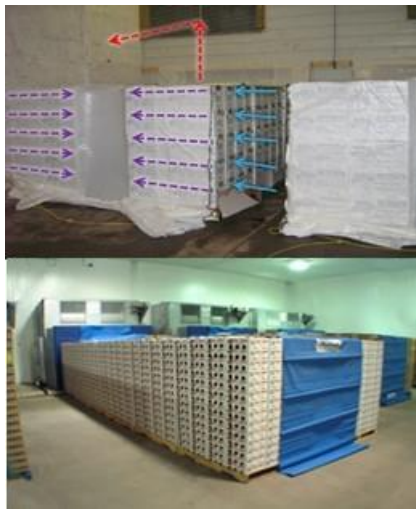
شکل ۳-۲- پیش‌سرد کردن محصول با جریان هوای فشرده (فائو، ۲۰۱۲)
