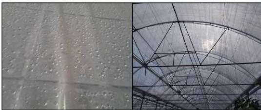
شکل ۳-۱۵: تراکم آب روی پوشش و کاهش ورود نور به داخل گلخانه (عکس از نگارندگان)
