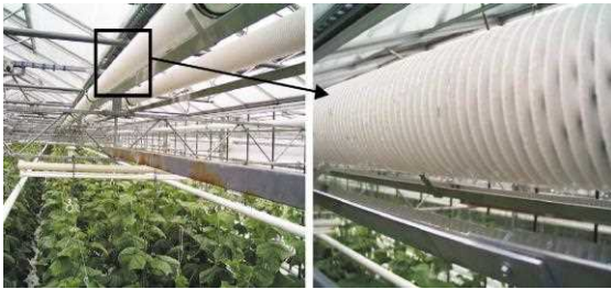
شکل ۴-۱۲: چگالش با استفاده از سطح سرد (کمپن و بات، ۲۰۰۲)
