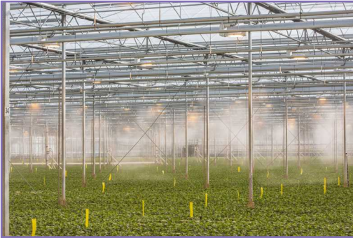
شکل ۴۸- سیستم مه پاش گلخانه‌ای
