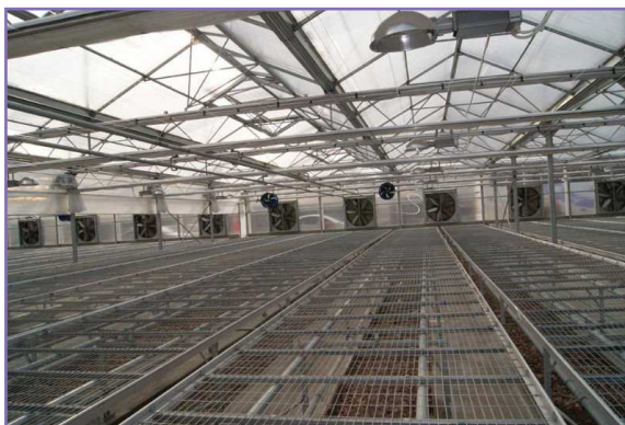
شکل ۴۶- نصب فن‌های تخلیه با فواصل منظم از یکدیگر و بالاتر از سطح کشت
