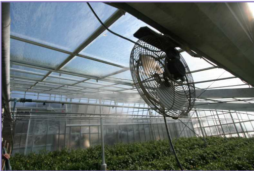
شکل ۴۹- توزیع یکنواخت ذرات آب با استفاده از جریان هوا
