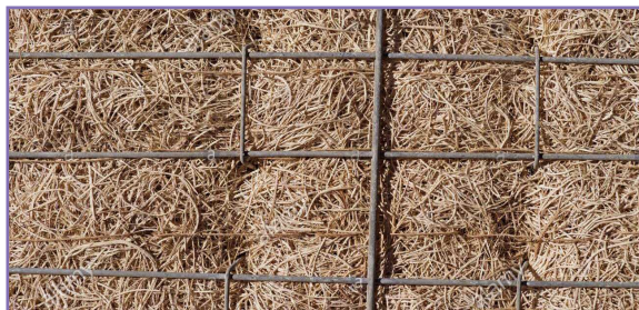
شکل ۳۶- پوشال سوزنی نصب شده در دیواره گلخانه
