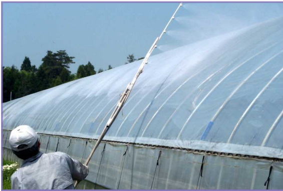
شکل ۱۳- رنگ پاشی پوشش گلخانه با استفاده از نازل سم پاش
