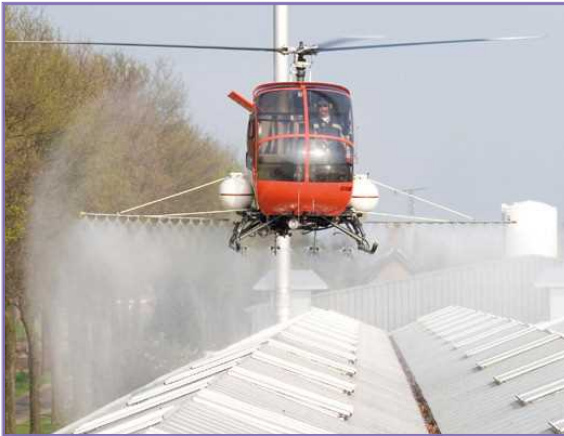
شکل ۱۲- رنگ آمیزی پوشش گلخانه با استفاده از هلیکوپتر
