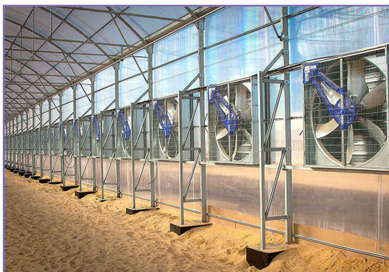
شکل ۲۸- نحوه قرارگیری فن‌های تخلیه روی دیواره عرضی گلخانه
