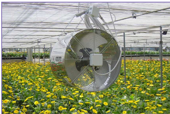
شکل ۲۳- فن سیرکوله برای گردش هوا در گلخانه
