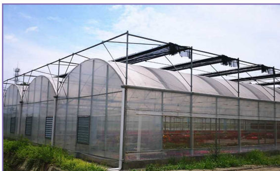
شکل ۶- نصب توری سایه‌انداز خودکار سطح بیرونی گلخانه
