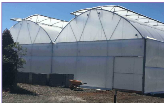
شکل ۲۰- نمونه‌ای از نحوه قرارگیری دریچه‌های سقفی در گلخانه‌های به هم پیوسته
