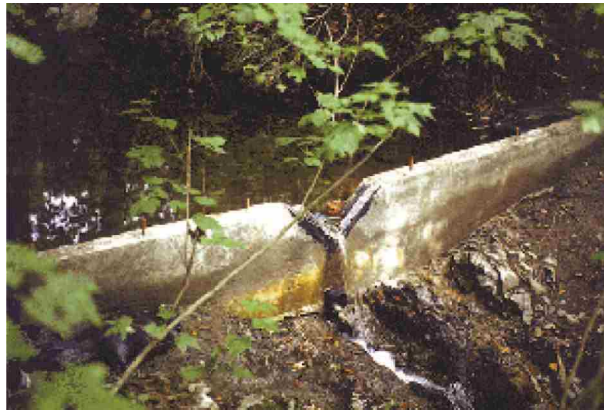
شکل ۴۶- نمایی از سرریز مثلثی ۹۰ درجه، نصب شده در مزرعه
