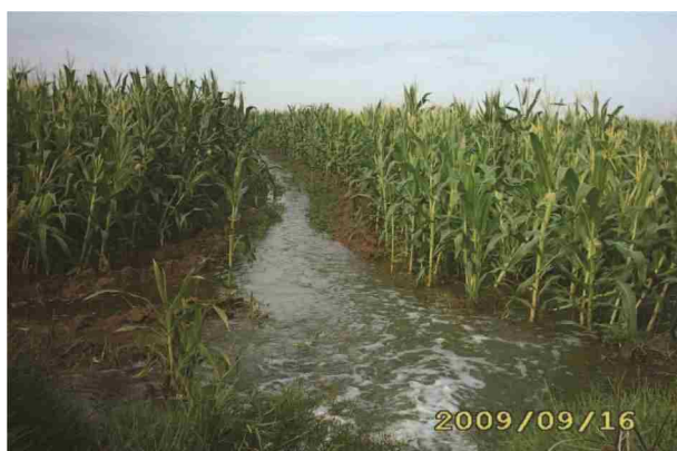
شکل ۹- نمایی از تخریب کانال در مزرعه به دلیل عدم انطباق جریان و سرعت آب با جنس کانال خاکی
