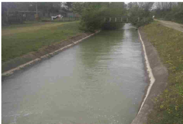
شکل ۷- نمونه‌ای از رعایت ارتفاع آزاد در کانال آبیاری
