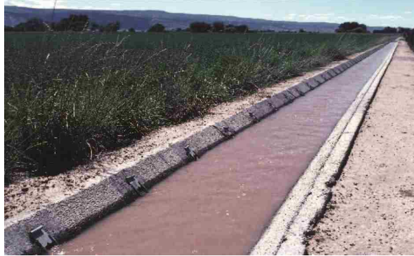
شکل ۵۳- نمایی از نحوه آبگیری اسپایل برای انتقال آب و آبیاری مزارع
