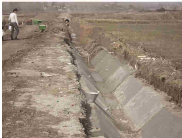
شکل ۶- نمایی از کانال آبیاری به شکل دوزنقه‌ای در حال ساخت
