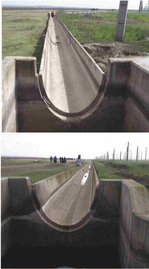
شکل ۴- نمایی از یک کانال با مقطع سهموی
