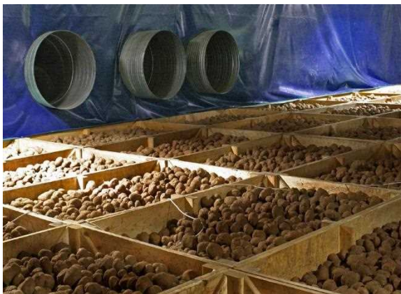
شکل ۱۸- پرده جدا کننده فضا در انبار با سامانه تهویه روباز منبع: (پیرینگل، ۱۹۹۲)
