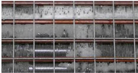
شکل ۲۷- مبدل حرارتی یک سامانهٔ سرماساز نیازمند یخ‌زدایی منبع: (اولسن و همکاران، ۲۰۱۱)
