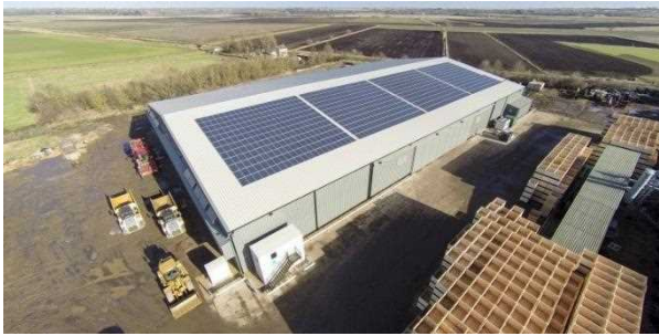
شکل ۳۱- استفاده از صفحه‌های خورشیدی برای تأمین بخشی از برق مصرفی انبار سیبزمینی منبع: ( https://www.southeastfarmer.net/ )
