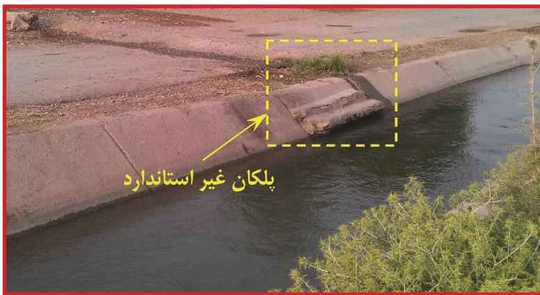
شکل ۵- محل غیراصولی دسترسی به آب کانال برای احشام
