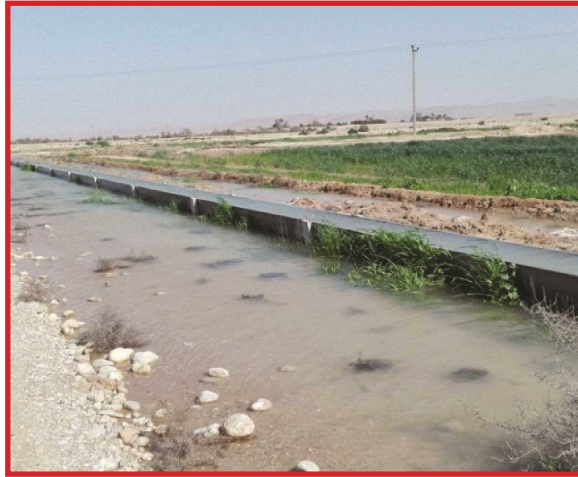
شکل ۴- استفاده اشتباه از کانالت
