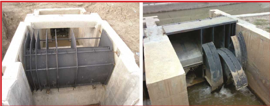
شکل ۱۰- یک نمونه دریچه مدول نیرپیک مورد استفاده در شبکه های آبیاری
