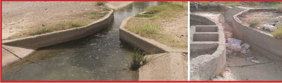
شکل ۸- سازه اندازه گیری آب بی استفاده (راست) و سازه در حال بهره برداری (چپ)
