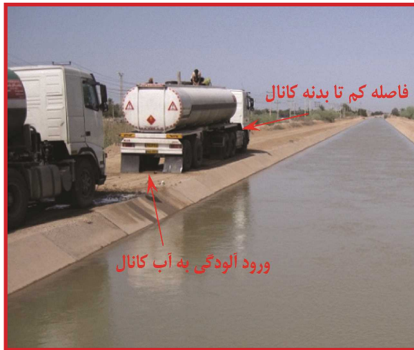
شکل ۱۱- شست و شوی ماشین با استفاده از کانال آبیاری
