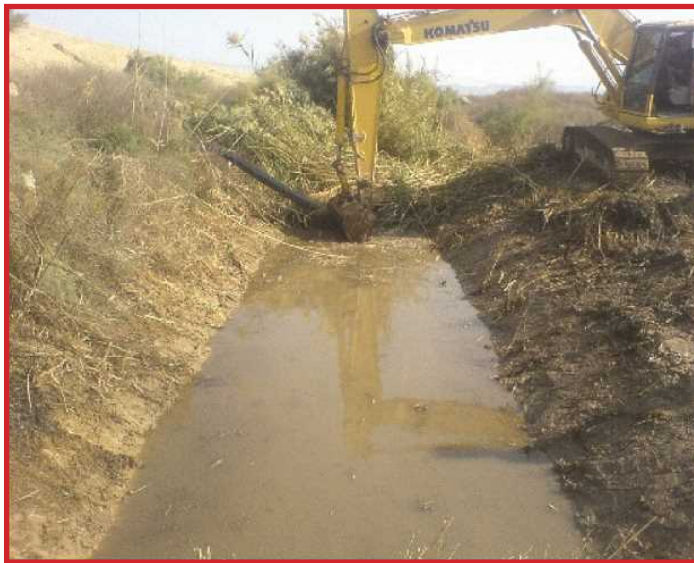
شکل ۷- نهر زهکشی پوشیده از علف های هرز (بالا) و نهر زهکشی در حال لایروبی (پایین)
