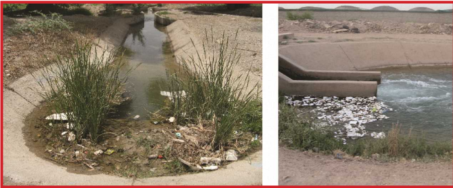
شکل ۹- ورود انواع آشغال شناور به کانال های آبیاری
