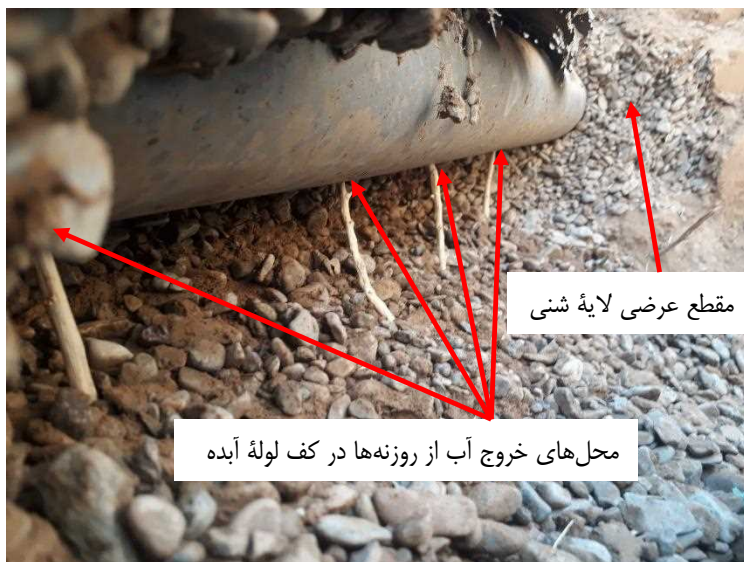
تصویر ۵- نمونه‌ای از محل خروجی آب روزنه‌ها به لایه شنی در ترائشه
