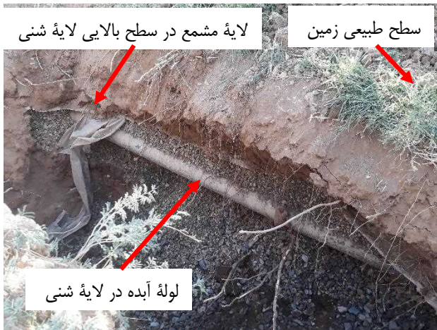
تصویر ۳- یک نمونه از پروفیل طولی اجرا شده (ابداعی کشاورزان پیشرو)
