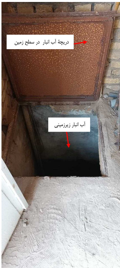
تصویر ۱۵- آب انبار زیرزمینی به منظور ذخیره کردن شیرابه کود دامی (ابداعی کشاورز پیشرو)
