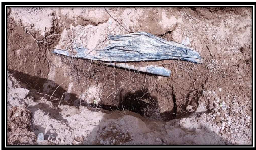
تصویر ۲۲- تجمع ریشه در محفظه شنی به واسطه پر شدن خلل و فرج آن از خاک
