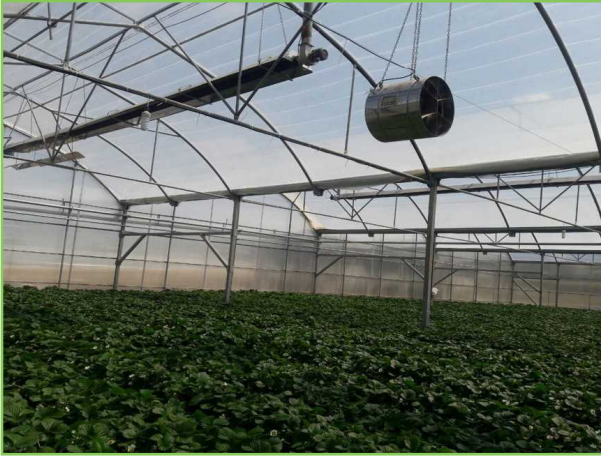
شکل ۲۹- سیستم گرمایش تابشی در گلخانه توت‌فرنگی همدان
