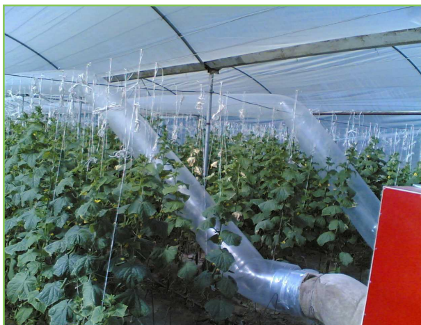
شکل ۲۶- استفاده از کوره هوای گرم در گرمایش گلخانه تولید خیار در جنوب استان کرمان
