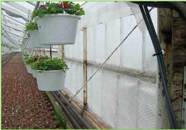
شکل ۱۶- اضافه کردن یک لایه پلی‌اتیلن شفاف زیر پوشش (استفاده از پلاستیک حباب‌دار)
