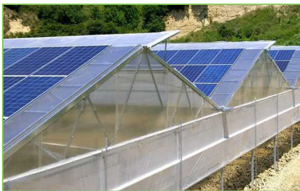
شکل ۳۵- استفاده غیرمستقیم از انرژی خورشیدی در گلخانه
