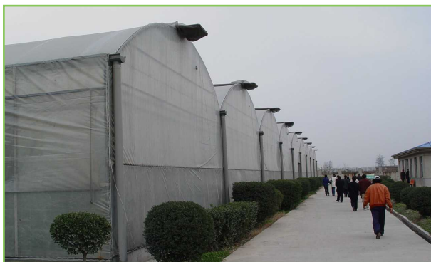
شکل ۱۷- گلخانه کمانی با پوشش دولایه
