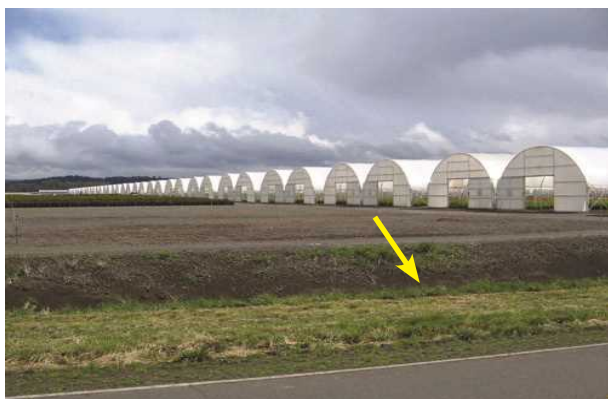
شکل ۵۱: بالابودن جای ساخت گلخانه نسبت به محیط پیرامون خود برای جلوگیری از آب گرفتگی گلخانه هنگام سیل آب و باران های شدید
