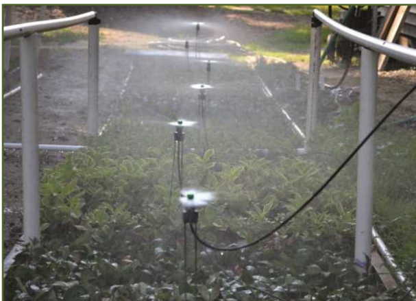
شکل ۲۵: نمونه‌ی از جریان چرخش آب در سیستم سرمایش تبخیری مه پاش کم فشار در گلخانه‌ها
