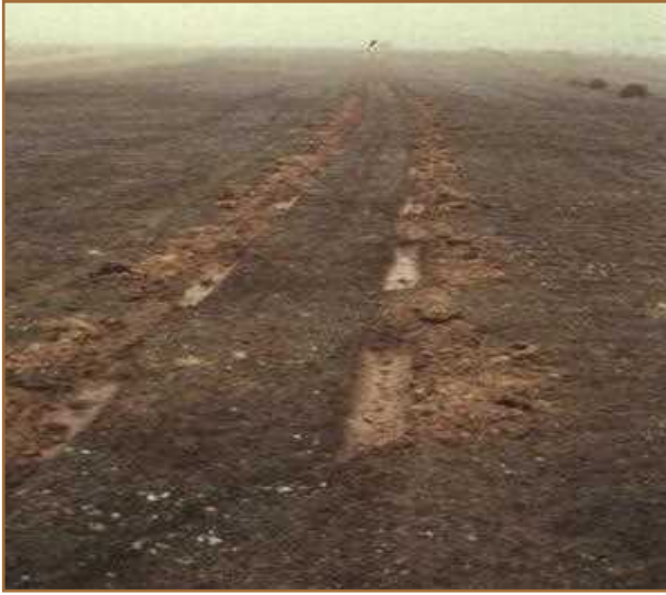
شکل ۵۲- عملیات پیتینگ با ایجاد خراش طولی در سطح خاک
