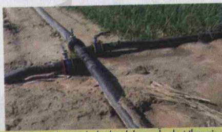
نحوه انشعاب آب در لوله های اصلی پنج لایه نخدار
