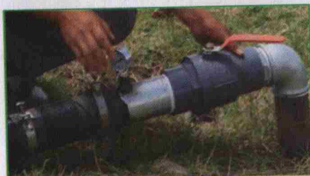
نحوه ابگیری لوله اصلی پنج لایه نخدار از منبع آب
