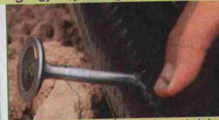
سوراخ ایجاد شده برای انشعاب آب از لوله اصلی پنج لایه نخدار
