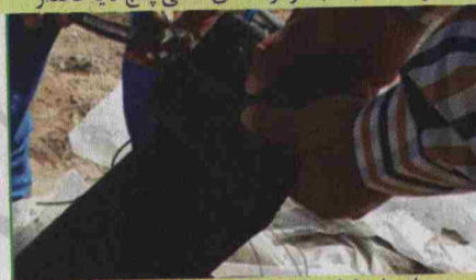
بستن انتهای لوله های پنج لایه نخدار با مقتول آهنی
