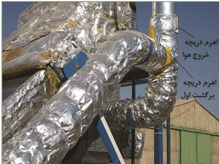
شکل ۱۴- دریچه‌های خروج هوا و برگشت هوای اول
