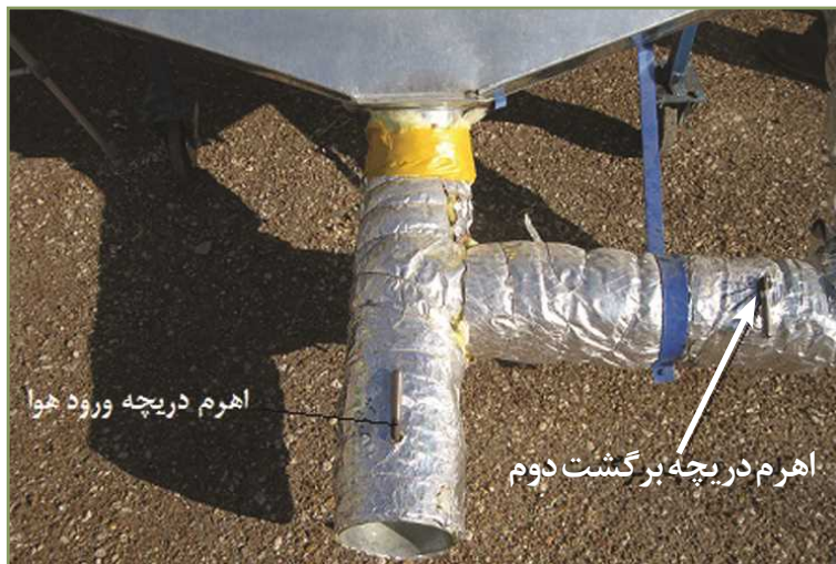
شکل ۱۵- دریچه‌های ورود هوا و برگشت هوای دوم
