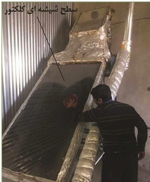
شکل ۱۰- تمیز کردن سطح شیشه‌ای واحد جمع‌کننده
