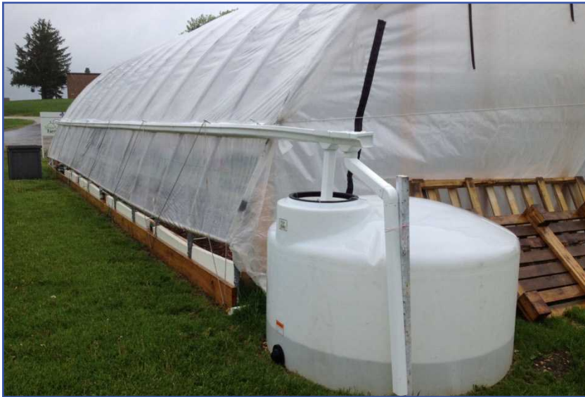
شکل ۱۲- جمع آوری آب باران از سقف گلخانه
