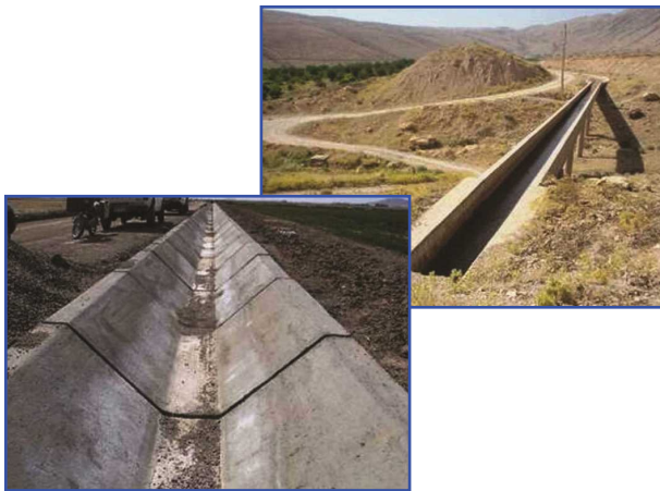
شکل ۲. استفاده از کانال‌های بتنی برای انتقال آب
